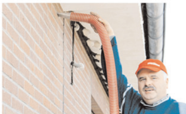
Das hochwertige Dämmmaterial bläst Udo Ottehenning in die Hohlraum des Mauerwerks ein.
