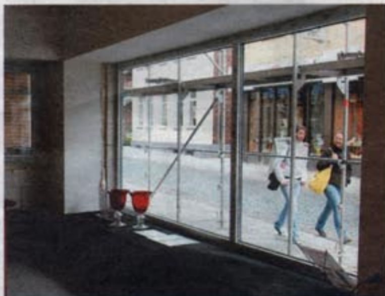
Die neuen Glasfronten des Küchentreffs funktionieren jetzt wie ein Wärmeschild. Insgesamt ist die Fensterfläche deutlich verkleinert worden.
