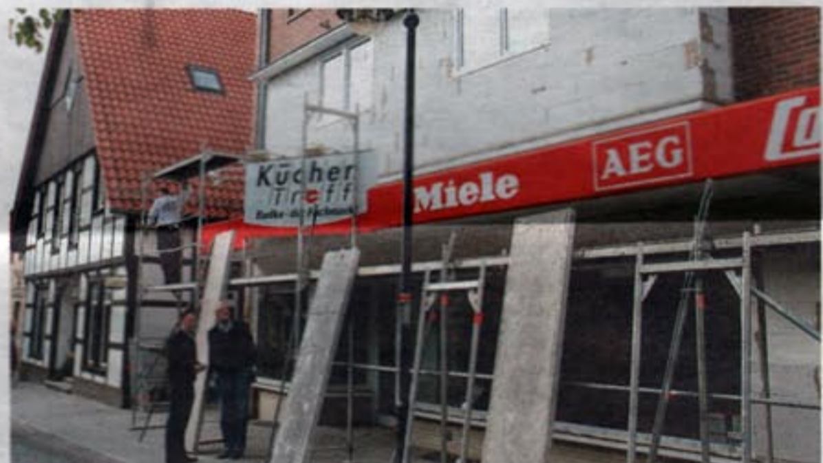
Heiko vor der Straße (G.E.S. Grafschafter Energiesparsysteme) und Inhaber Gerhard Budke (v.l.) beobachten die Bauarbeiten zur Neugestaltung der Geschäftsräume. Fotos (2): Grüter
